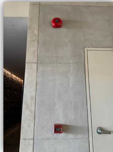
ภาพที่ 92 แสดงอุปกรณ์แจ้งเหตุสัญญาณเพลิงไหม้
