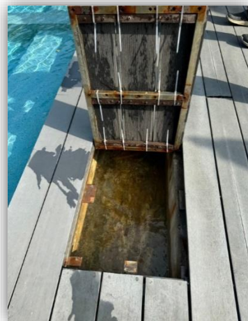
ภาพที่ 102 แสดงรางระบายน้ำมีฝาปิด ระบบสกมเมอร์
