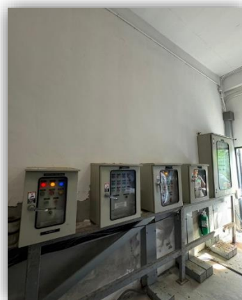
ภาพที่ 66 แสดงมิเตอร์ไฟฟ้าของระบบบำบัดน้ำเสีย รวมระบบปรับอากาศ
