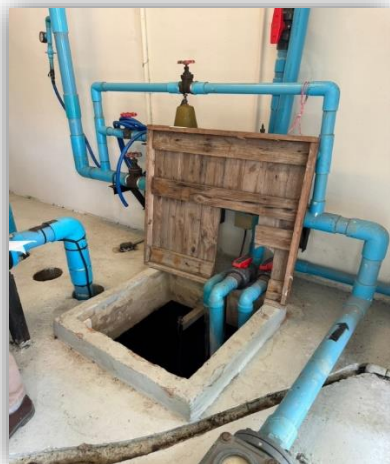
ภาพที่ 69 แสดงถังเก็บน้ำสำรองใต้ดิน
