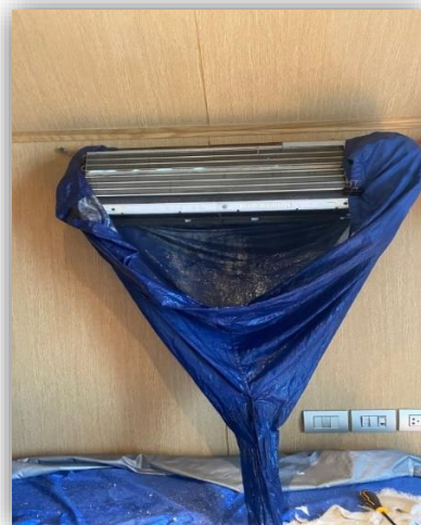
ภาพที่ 126 แสดงการทำความสะอาดเครื่องปรับอากาศ
