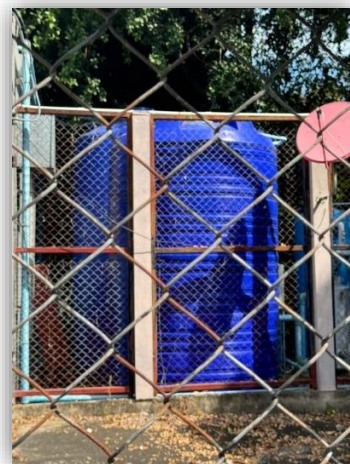
ภาพที่ 70 แสดงถังเก็บน้ำสำรอง ความจุ 60 ลบ.ม
