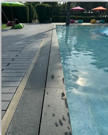
ภาพที่ 103 แสดงรางระบายน้ำมีฝาปิด ระบบสกมเมอร์
