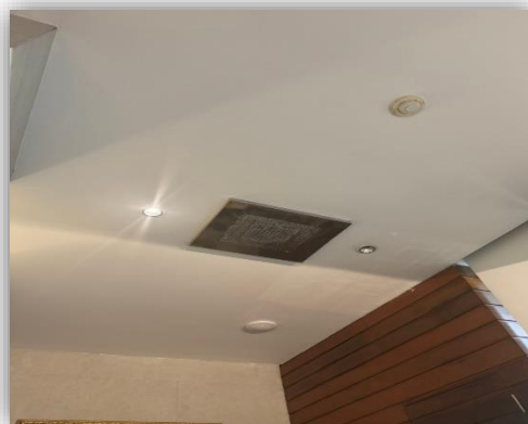
ภาพที่ 94 แสดงอุปกรณ์ตรวจจับความร้อน (Heat Detector) ภายในอาคาร
