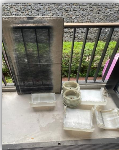
ภาพที่ 125 แสดงการทำความสะอาดเครื่องปรับอากาศ
