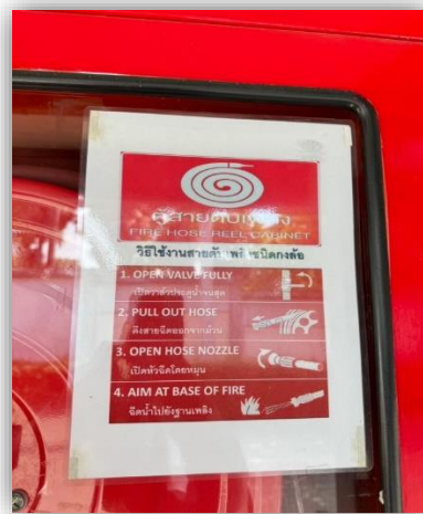
ภาพที่ 72 แสดงวิธีการใช้อุปกรณ์ดับเพลิง
